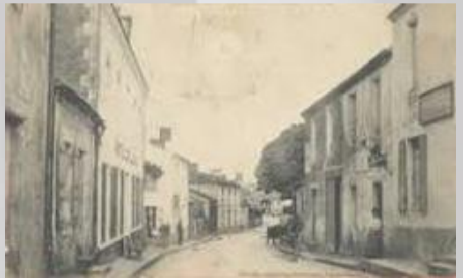
Phot n° 2 : Rue des Sables
